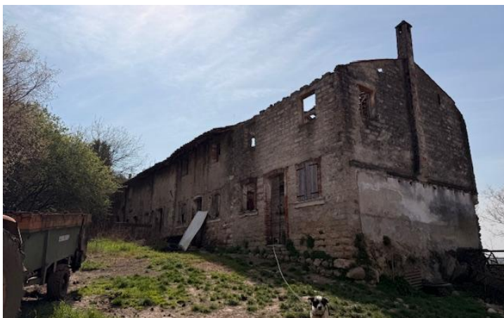
Foto 1 – vista prospetti Nord ed Est
