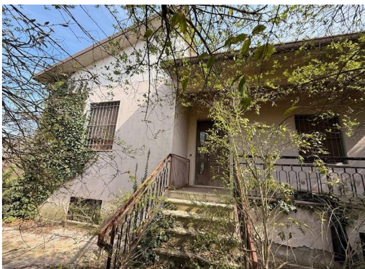
Figura 6 e 7 - vista del prospetto principale - ovest
