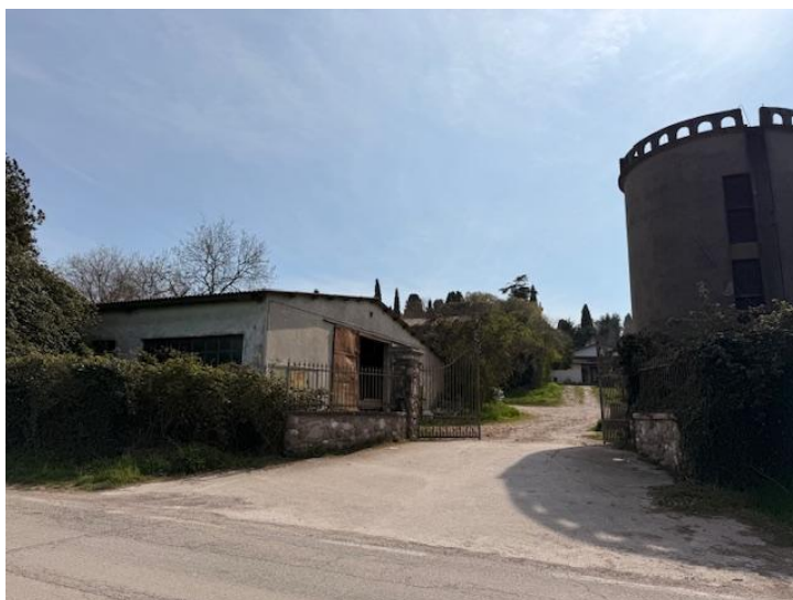
Foto 5 –accesso dalla strada Staffalo.
